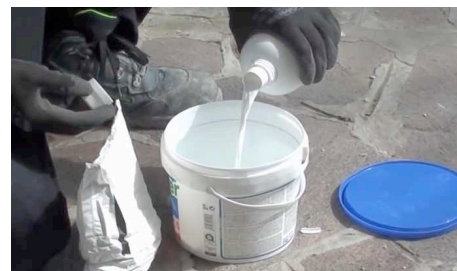
Preparazione passivante per ferri di armatura
