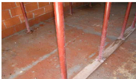
Fissaggio del puntello alla tavola distributrice a terra
