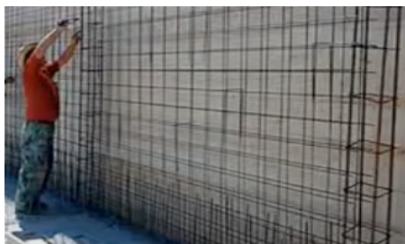
Posa di barre di armatura nelle zone di progetto
