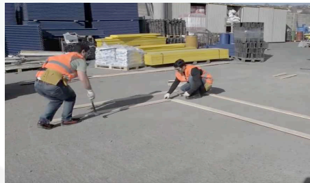
Fissaggio tavole perimetrali
