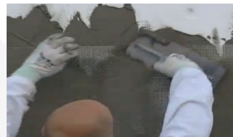
Fare aderire la rete rasatura con spatola
