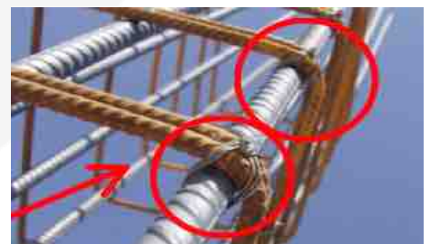
Effettuazione delle legature in opera
