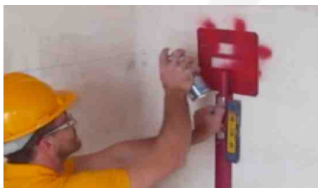
Traccia a parete collocamento impianti
