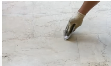
Stuccatura delle imperfezioni eseguita manualmente
