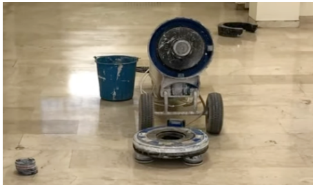
Preparazione dischi levigatrice
