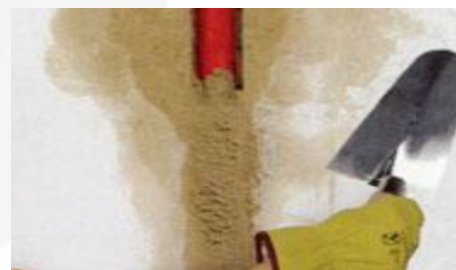
Riempimento tracce con malta specifica
