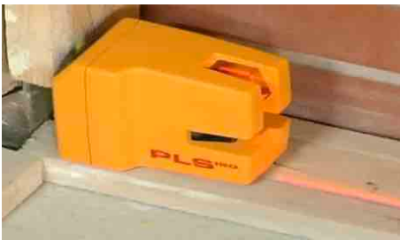
Tracciamento dei profili sulla muratura oggetto di intervento
