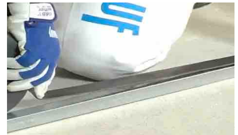
Posa del nastro di guarnizione sui profili metallici
