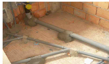
Fissaggio con getto delle tubazioni
