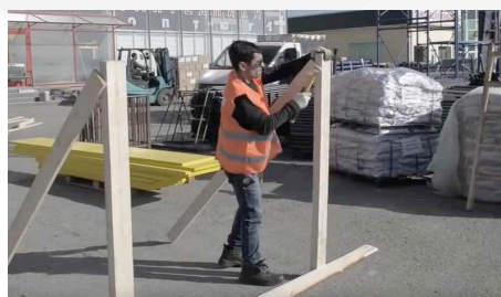
Posizionamento tavole verticali e diagonali
