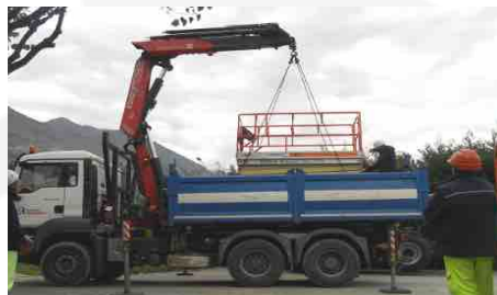
Imbracco del carico e verifica tenuta complessiva
