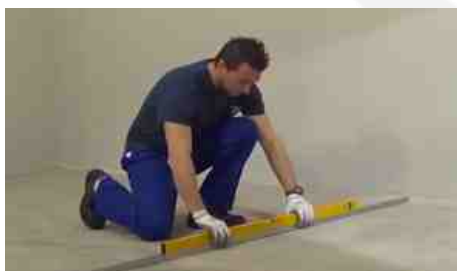
Controllo della planarità del sottofondo
