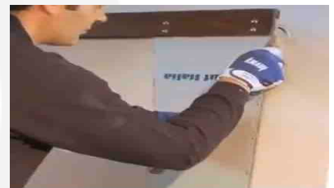
Taglio delle lastre in prossimità del tracciamento eseguito
