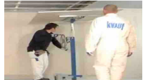
posa delle lastre con l'ausilio di un montalastre
