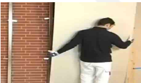
Posizionamento delle lastre sulla struttura metallica di sostegno
