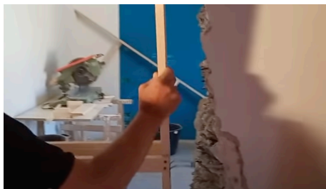
Posa telaio nel punto di alloggio predisposto
