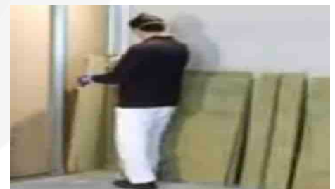
Se previsto dal capitolato si riempirà la il vano interno con pannelli di fibra minerale dimensionati a necessità
