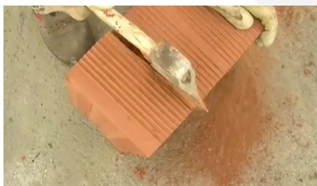
Taglio mattone della misura necessaria
