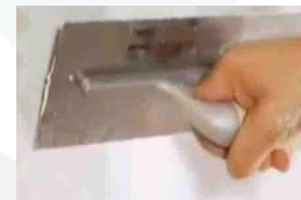
con una spatola si rimuove lo stucco e l'aria presente
