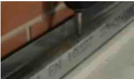
Si realizzerà il foro sul pavimento o muratura per il posizionamento di tasselli di trattenuta
