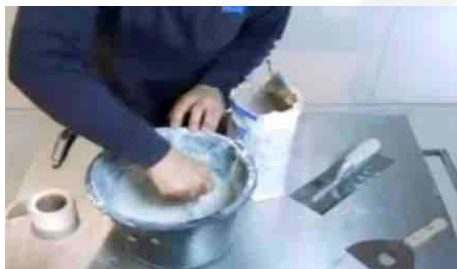
creazione dello stucco necessario
