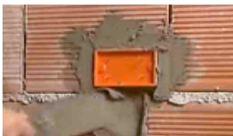
Completamento fissaggio scatola
