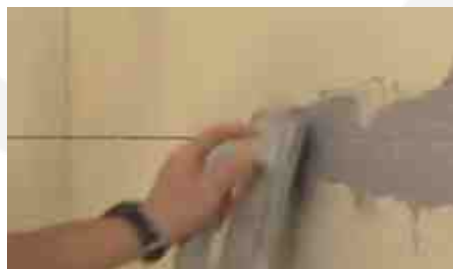
Posa stucco all'interno delle fughe verticali
