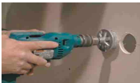
Identificata la posizione del frutto e/o punto luce verrà effettuato il foro mediante tazza
