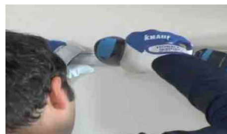
Fissaggio profili perimetrali di sostegno
