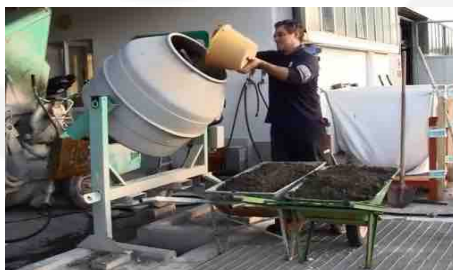
Attivazione macchina e aggiunta di acqua
