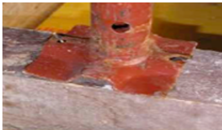
Posa di morali e fissaggio dei puntelli con chiodi
