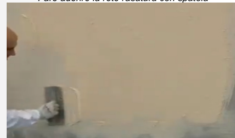
Stendere la finitura plastica a completamento e sfrattonare manualmente
