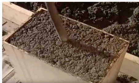
Inserimento dell'ago vibrante in posizione verticale
