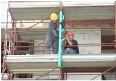
Assemblaggio e verifica del fissaggio e verticalità
