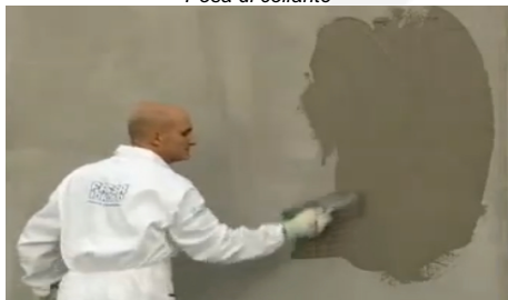
Rasare con una seconda mano di collante la rete precedentemente posata
