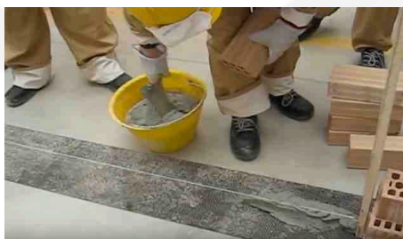
Posa malta cementizia nell'area di posa
