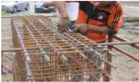
Posa di ferro nelle zone di assemblaggio
