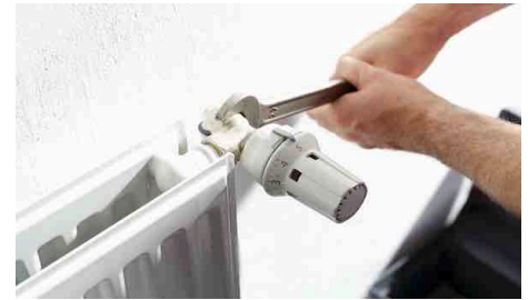
Installazione valvole
