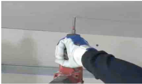
Tracciamento e posa dei pendini di sostegno
