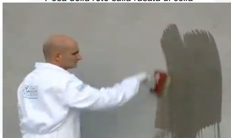
Stendere il fissativo con pennellina
