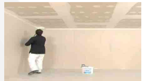
posa di primer al supporto realizzato
