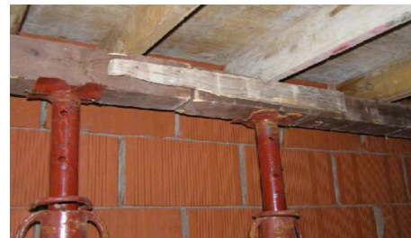
Elevazione puntelli alla quota di progetto
