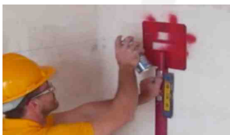
Traccia a parete collocamento impianti
