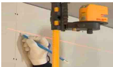
Posizionamento laser per tracciamento quote
