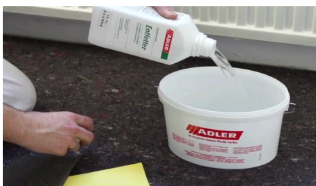
Preparazione sverniciante e posa con pennello
