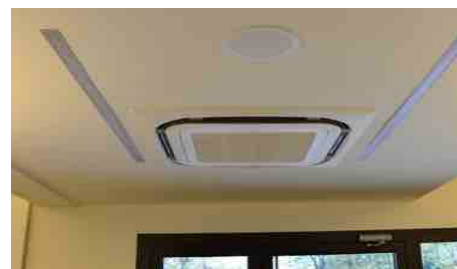
Installazione bocchettoni di uscita
