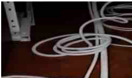
Predisposizione cavo elettrico e tubo gas refrigerante
