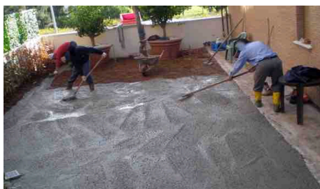
Stesura del calcestruzzo mediante rastrello
