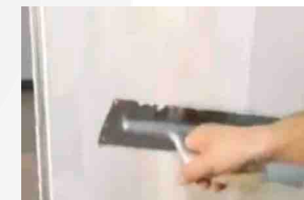
stesura dell'ultima mano di stucco a finitura
