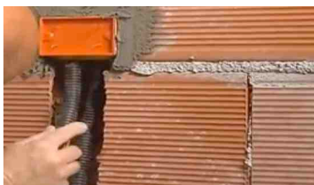
Collegamento corrugato alla scatola posata
