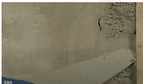
Posa carpenteria di contenimento e posa malta
