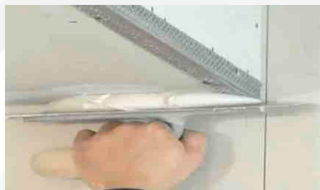
posa di eventuali paraspigoli ed effettuazione di stuccature
