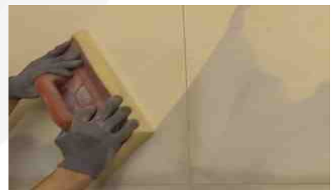
Rimozione residui con spugna umida
