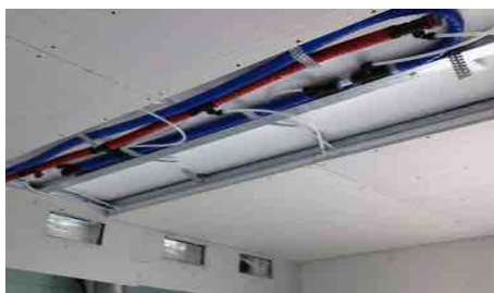
Fissaggio tubazioni impianto
