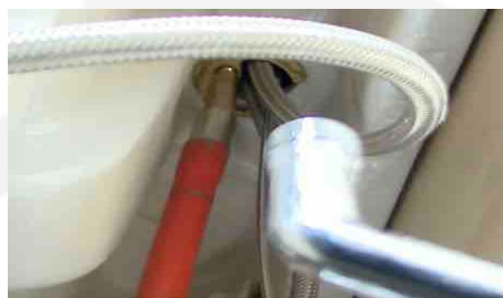
Fissaggio ai sanitari delle rubinetterie
