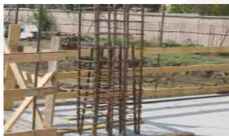
Posa gabbia metallica su ferri di ripresa
