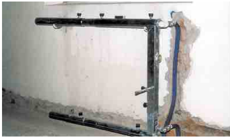
Predisposizione impianto idrico
