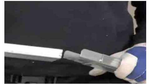
Posa giunti lineari se necessari
