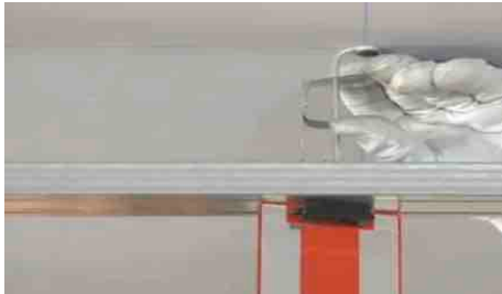
regolazione dei ganci di sostegno alle quote di progetto
