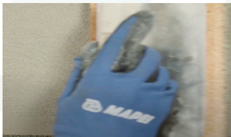
Sfrattonatura della superficie
