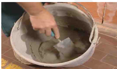
Preparazione della malta necessaria
