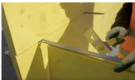
Posa distanziatori in prossimità degli spigoli
