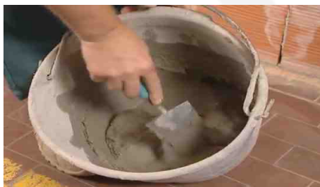
Preparazione della malta necessaria
