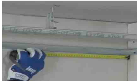
posa dell'orditura secondaria sui profili perimetrali guida
