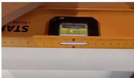
Verifica allineamento e verticalità
