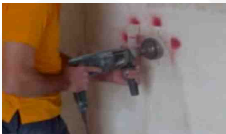
Demolizione con elettrotensili
