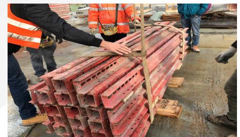
Collegamento accessorio ed effettuazione dei tiri / cali
