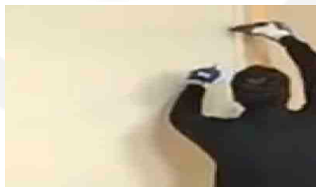
Fissaggio della lastra al supporto metallico realizzato
