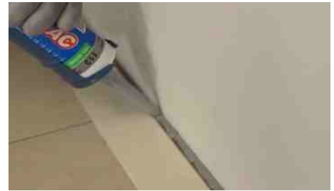
Siliconatura giunti di dilatazione
