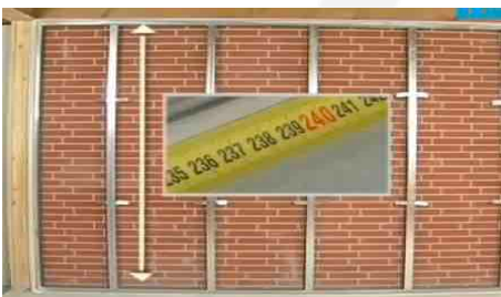
Effettuazione dei rilevamenti metrici per il corretto dimensionamento delle lastre
