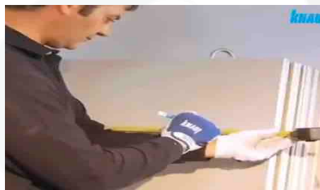
Approvvigionamento nell'area di lavoro delle lastre e tracciamento delle zone da rimuovere
