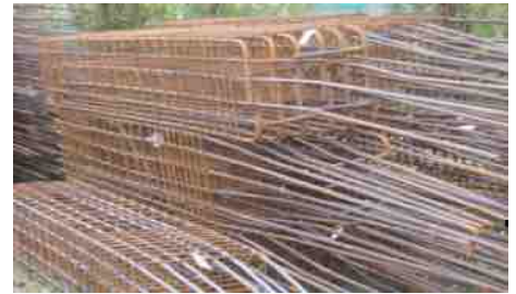
Accatastamento travi assemblate
