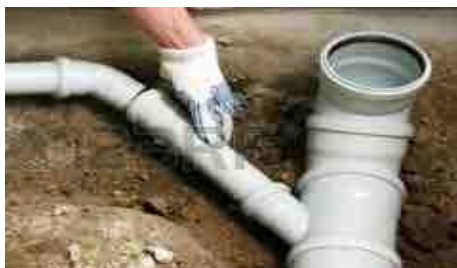
Fissaggio tubazioni previa verifica livelli
