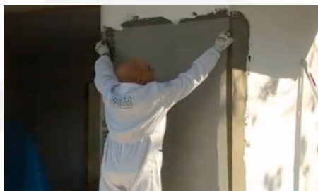
Posa della rete sulla rasata di colla
