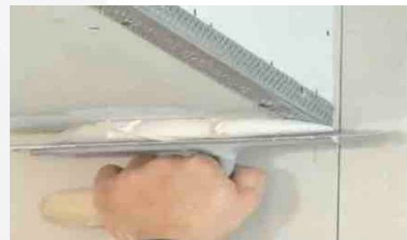
stesura dello stucco sui giunti e angolari
