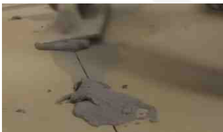
Posa stucco all'interno delle fughe orizzontali
