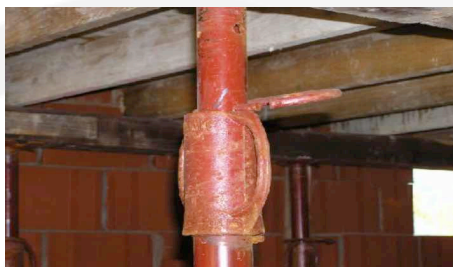
Messa in tiro del puntello attraverso il vitone
