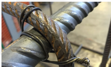
Legatura manuale dei ferri di armatura
