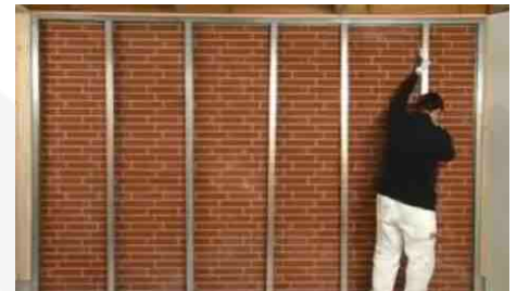
Si completerà l'orditura con la messa a bolla delle strutture
