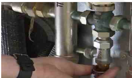
Scaricare l'acqua presente nell'impianto
