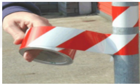
Fissaggio nastro a strutture esistenti
