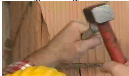
Demolizione localizzata per ancoraggio
