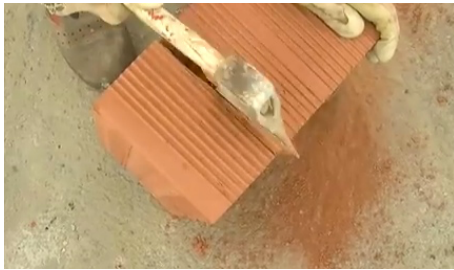
Taglio portoton della misura necessaria
