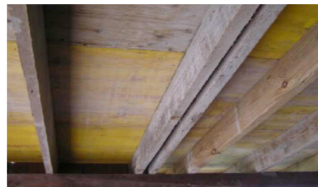
Inchiodatura dei pannelli di contenimento del getto
