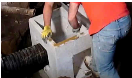
Posa pozzetti in area di posa
