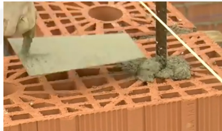
Posa ferri nei fori e chiusura con malta
