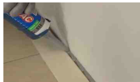
Siliconatura giunti di dilatazione
