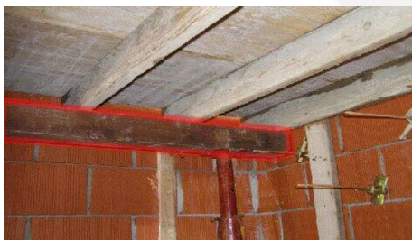
Posizionamento prima banchina
