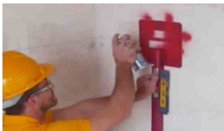
Traccia a parete collocamento impianti
