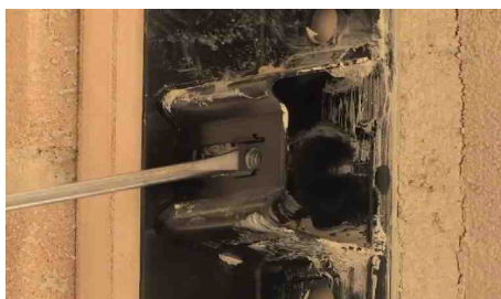
Allineamento femmine di fissaggio
