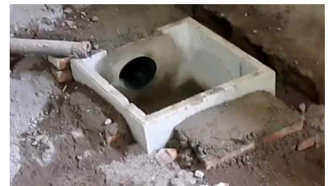
Chiusura con malta e ricoprimento con terra
