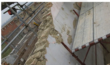
Pulizia muratura e demolizioni localizzate
