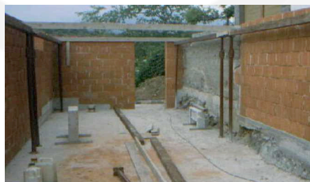
Posizionamento parallele di costa
