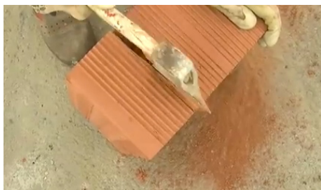
Taglio mattone della misura necessaria
