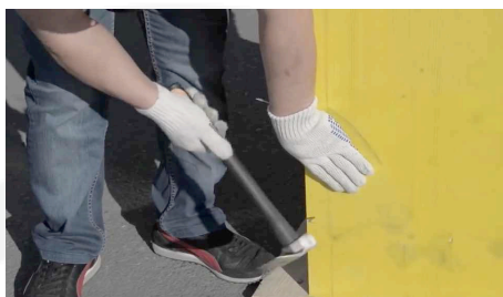
Fissaggio primi due pannelli ad angolo
