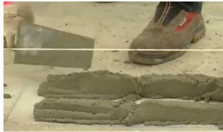
Posa malta cementizia nell'area di posa
