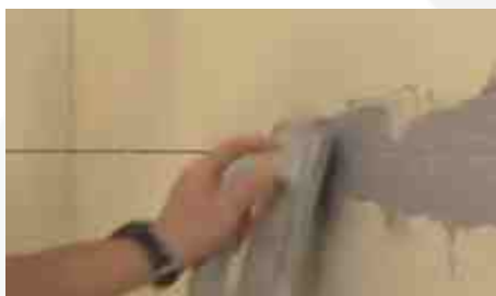
Posa stucco all'interno delle fughe verticali
