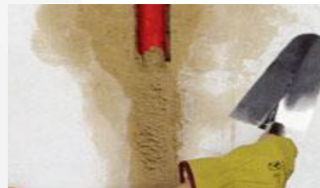
Riempimento tracce con malta specifica
