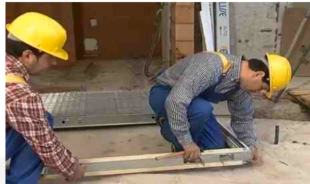
Sballaggio e assemblaggio controtelaio
