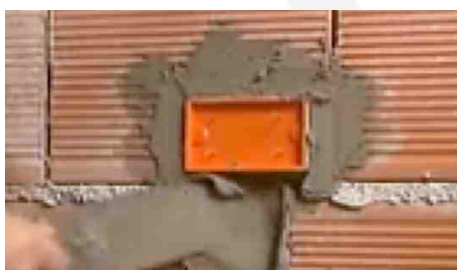
Completamento fissaggio scatola
