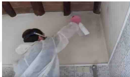
Eventuale pulizia e/o rimozione muffe
