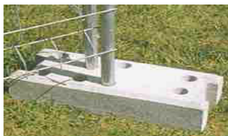
Posizionamento basette e rete
