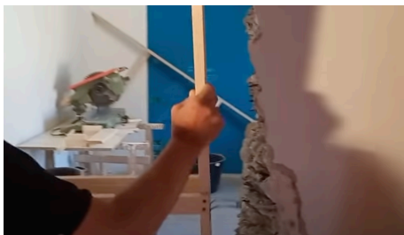
Posa telaio nel punto di alloggio predisposto
