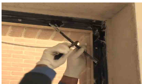
Rimozione sostegni controtelaio
