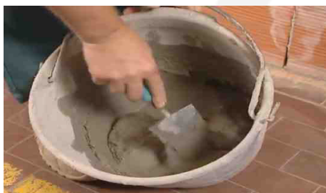
Preparazione della malta necessaria
