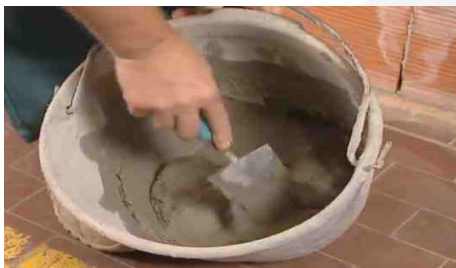
Preparazione della malta necessaria
