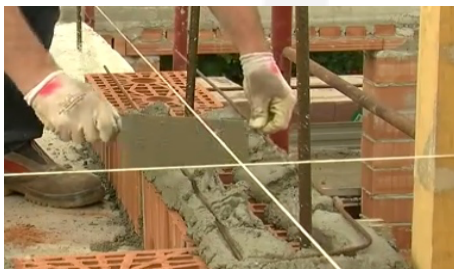
Posa di ferri di trattenuta longitudinali
