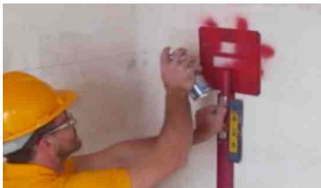
Traccia a parete collocamento impianti
