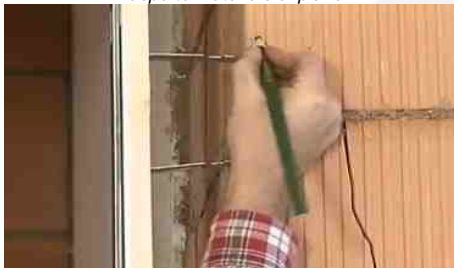
Traccia parti oggetto di demolizione
