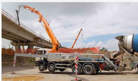
Posizionamento autopompa
