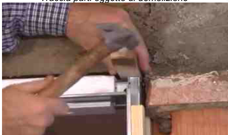
Posa di bitte a fermo del controtelaio
