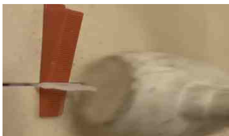
Rimozione distanziatori con martello manuale
