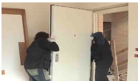
Posizionamento porta e allineamento
