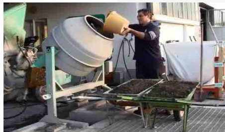
Attivazione macchina e aggiunta di acqua
