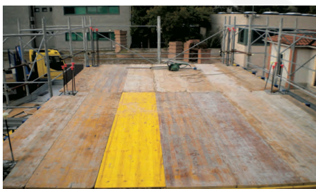
Controllo del banchinaggio
