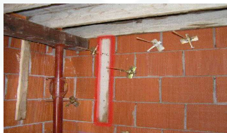
Inchiodatura tavola senza precisione
