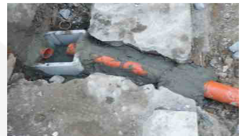
Fissaggio con getto delle tubazioni
