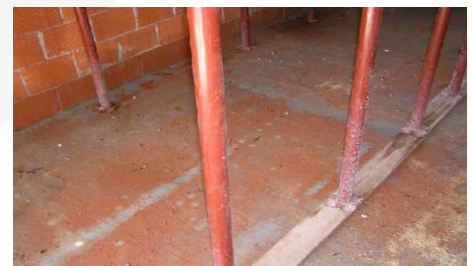
Posizionamento puntelli e banchine
