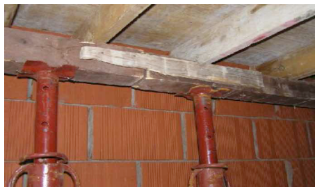
Ove necessario collegamento tra le banchine
