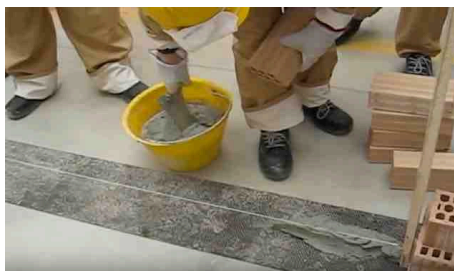
Posa malta cementizia nell'area di posa
