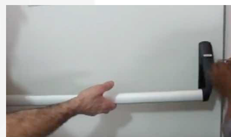
Istallazione maniglione antipanico
