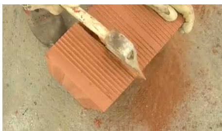
Taglio mattone della misura necessaria
