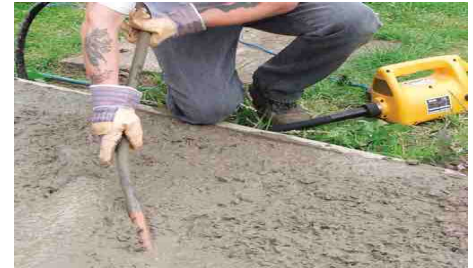
Vibratura e staggiatura del getto
