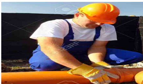
Fissaggio tubazioni previa verifica livelli
