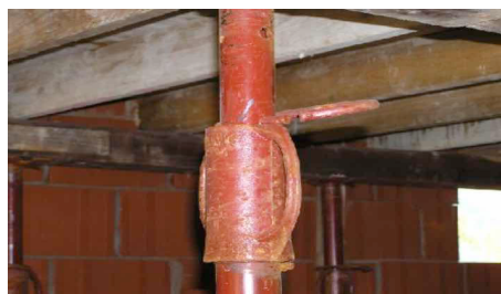
Bloccaggio puntello alla quota necessaria
