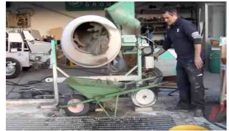
Posizionamento della malta risultante nella carriola
