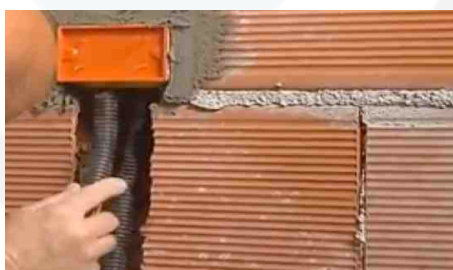
Collegamento corrugato alla scatola posata
