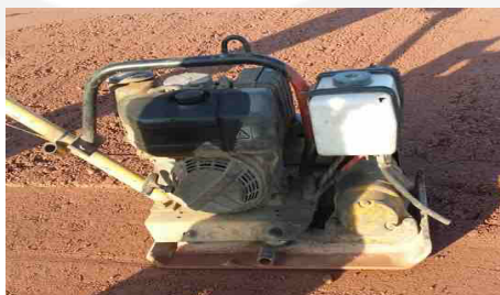
Posa stabilizzato e battitura
