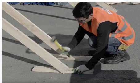
Fissaggio diagonali
