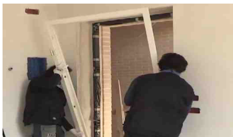
Posizionamento telaio
