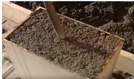
Inserimento dell'ago vibrante in posizione verticale
