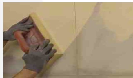
Rimozione residui con spugna umida
