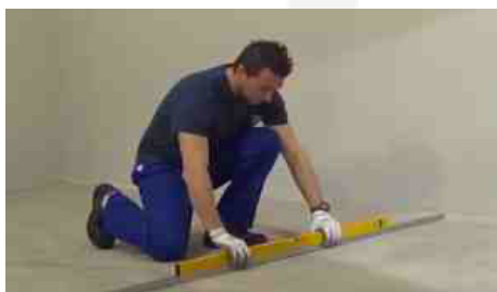
Controllo della planarità del sottofondo
