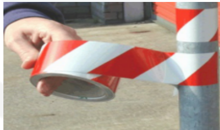
Fissaggio nastro a strutture esistenti
