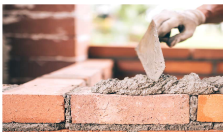
Posa malta cementizia nell'area di posa
