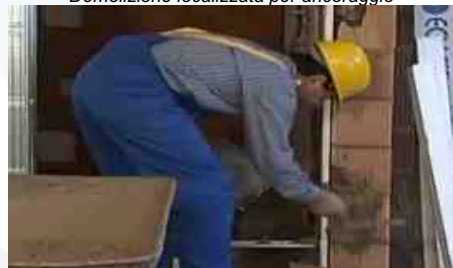
Fissaggio con malte del controtelaio
