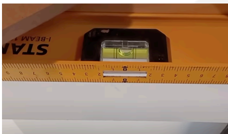
Verifica allineamento e verticalità
