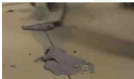
Posa stucco all'interno delle fughe orizzontali
