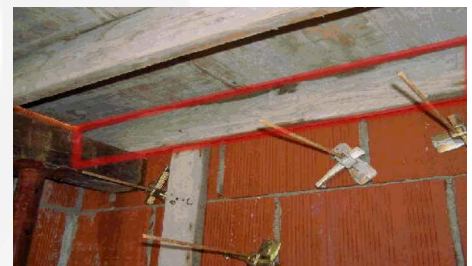
Inchiodatura prima parallela "costa" con precisione
