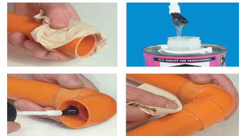
Posa collante Tangit per effettuazione collegamenti
