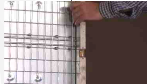
Controllo livelli controtelaio
