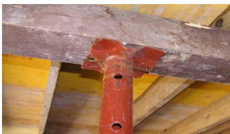
Inchiodatura puntelli a banchine
