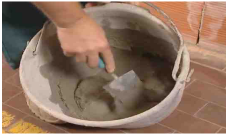
Preparazione delle malte cementizie
