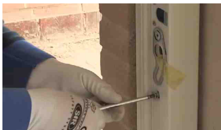
Fissaggio telaio al controtelaio con viti
