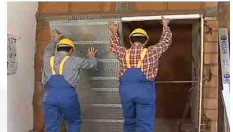
Elevazione in quota controtelaio
