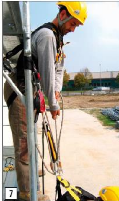
7 - trazione le funi che escono dall'anello effettuando dei piegamenti con le gambe. Il dispositivo I'D recupererà e bloccherà automaticamente la fune carica. Sollevare l'infortunato di pochi cm quanto basta per staccare il suo anticaduta
