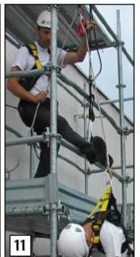
11 - Impugnare la fune scarica. Azionare la leva di sblocco. Calare l'infortunato cercando di distanziarlo dalla struttura
