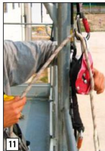
11 - Impugnare la fune scarica. Azionare la leva di sblocco. Calare l'infortunato cercando di distanziarlo dalla struttura
