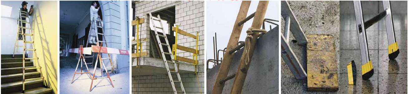
UTILIZZI CORRETTI: Utilizzi corretti della scala: lunghezze regolabili, delimitazione aree di lavoro, sbarco al piano con protezioni, appoggi e fissaggi corretti
