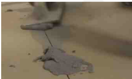
Posa stucco all'interno delle fughe orizzontali
