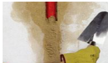
Riempimento tracce con malta specifica
