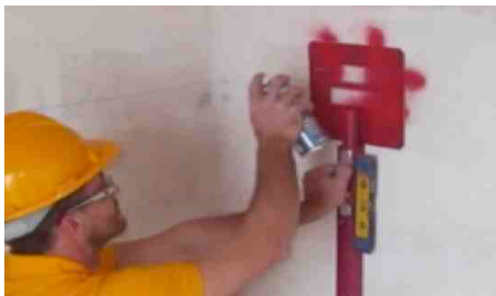
Traccia a parete collocazione impianti
