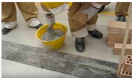
Posa malta cementizia nell'area di posa
