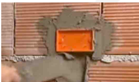
Completamento fissaggio scatola
