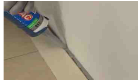
Siliconatura giunti di dilatazione
