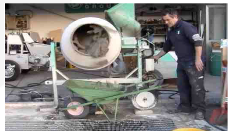
Posizionamento della malta pronta nella carriola
