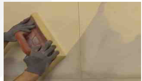
Rimozione residui con spugna umida
