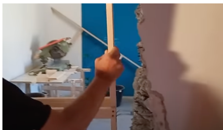
Posa telaio nel punto di alloggio predisposto
