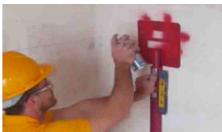
Traccia a parete collocamento impianti
