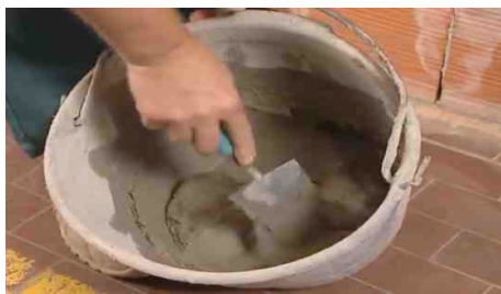
Preparazione della malta necessaria
