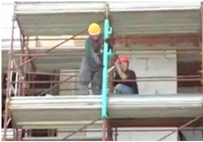
Assemblaggio e verifica del fissaggio e verticalità
