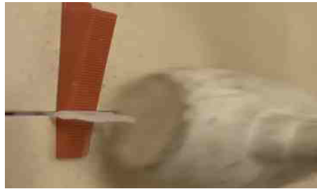
Rimozione distanziatori con martello manuale
