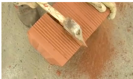
Taglio mattone della misura necessaria
