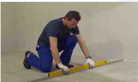
Controllo della planarità del sottofondo
