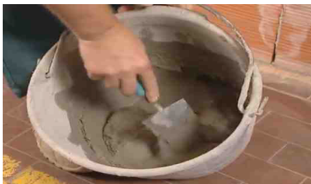
Preparazione della malta necessaria
