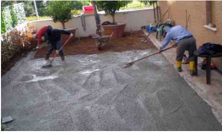
Stesura del calcestruzzo mediante rastrello
