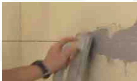
Posa stucco all'interno delle fughe verticali
