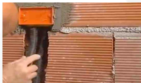
Collegamento corrugato alla scatola posata
