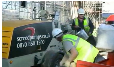
Caricamento nella tramoggia di cementi e acqua
