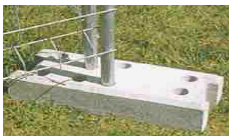
Posizionamento basette e rete
