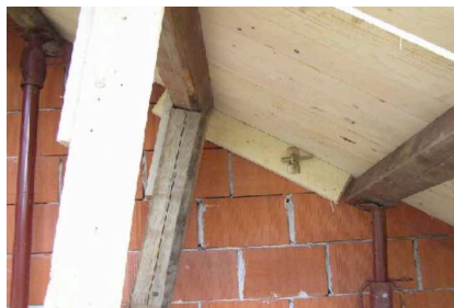
Fissaggio tavoletta verifica quota e tavole sottoscala
