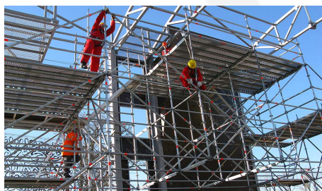
Montaggio di opere provvisori
