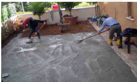
Stesura del calcestruzzo mediante rastrello
