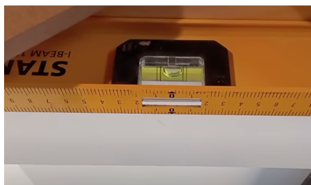
Verifica allineamento e verticalità
