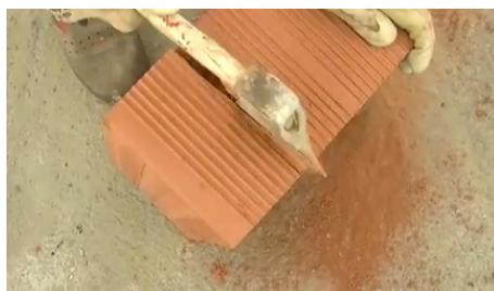
Taglio portoton della misura necessaria
