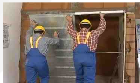
Elevazione in quota controtelaio
