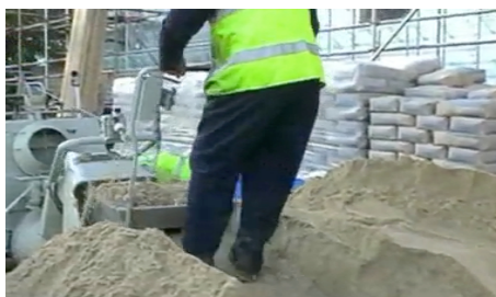
Carico della tramoggia con pala meccanica e argano
