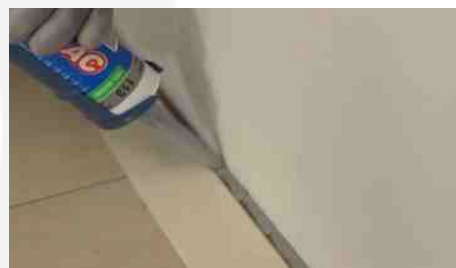
Siliconatura giunti di dilatazione
