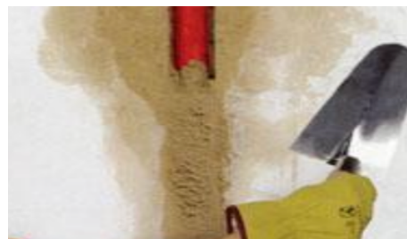
Riempimento tracce con malta specifica
