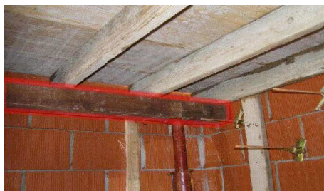
Posizionamento prima banchina
