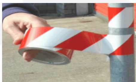
Fissaggio nastro a strutture esistenti
