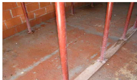
Posizionamento puntelli e banchine
