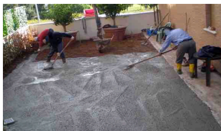
Stesura del calcestruzzo mediante rastrello
