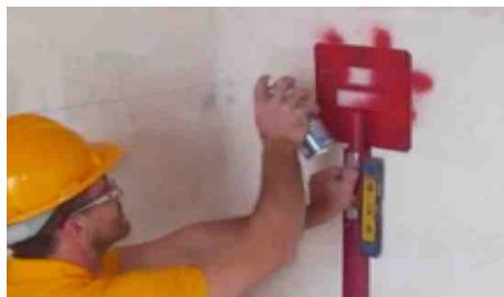
Traccia a parete collocamento impianti
