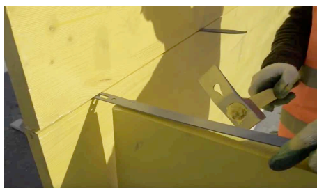
Posa distanziatori in prossimità degli spigoli
