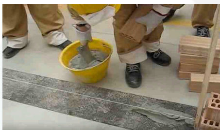
Posa malta cementizia nell'area di posa
