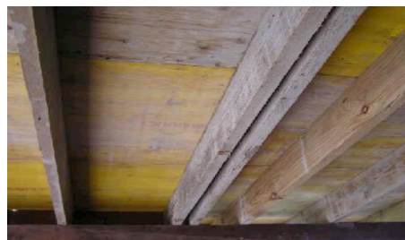
Inchiodatura dei pannelli di contenimento del getto
