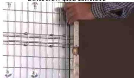
Controllo livelli controtelaio
