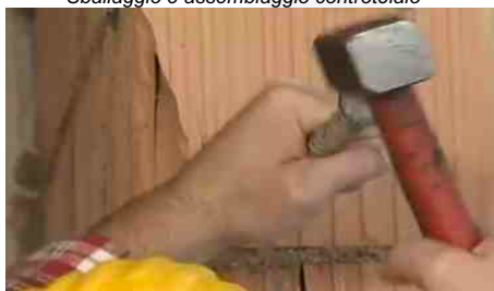
Demolizione localizzata per ancoraggio
