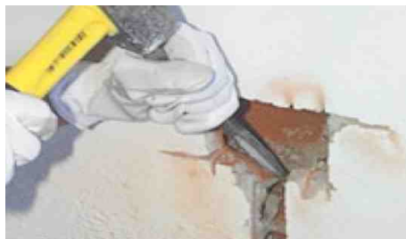
Rimozione parti ammalorate aree di rinzafo
