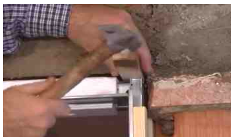
Posa di bitte a fermo del controltaio
