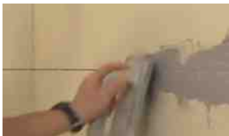
Posa stucco all'interno delle fughe verticali
