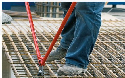
Ridimensionamento reti manuale
