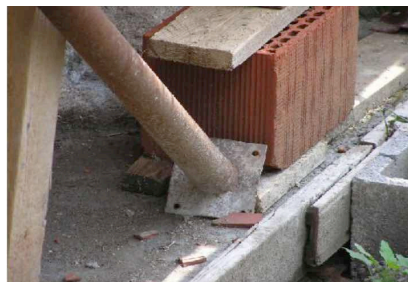
Posizionamento puntello diagonale
