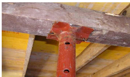
Inchiodatura puntelli a banchine
