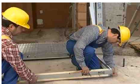
Sballaggio e assemblaggio controtelaio
