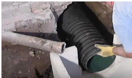
Collegamenti scarichi e tubazioni di raccordo
