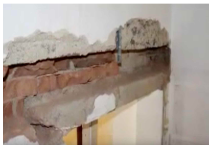
Demolizione porzione di muratura e pulizia
