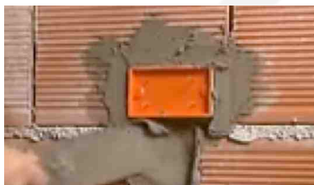
Completamento fissaggio scatola
