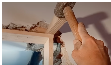
Posa bitte per il fissaggio del telaio alla muratura
