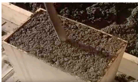
Inserimento dell'ago vibrante in posizione verticale
