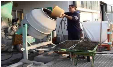
Attivazione macchina e aggiunta di acqua
