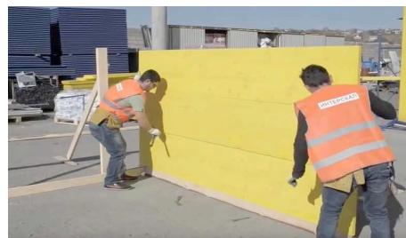
Fissaggio pannelli
