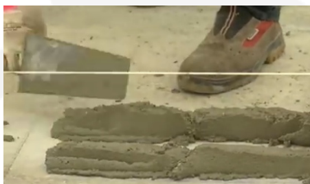
Posa malta cementizia nell'area di posa
