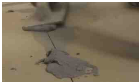
Posa stucco all'interno delle fughe orizzontali
