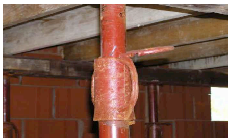
Bloccaggio puntello alla quota necessaria
