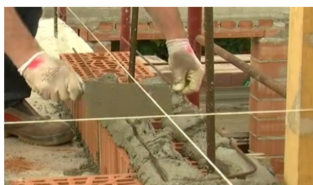
Posa di ferri di trattenuta longitudinali
