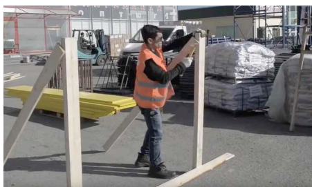
Posizionamento tavole verticali e diagonali
