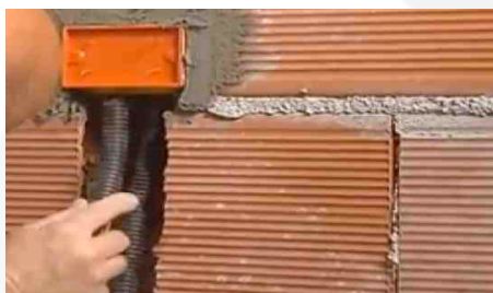
Collegamento corrugato alla scatola posata
