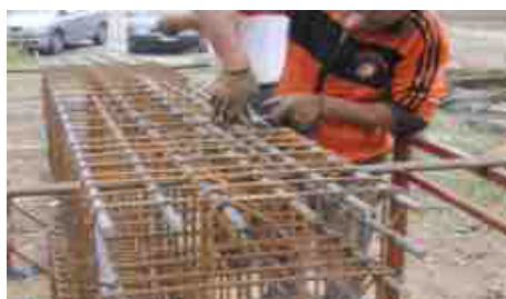
Posa di ferro nelle zone di assemblaggio
