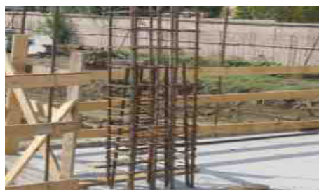
Posa gabbia metallica su ferri di ripresa
