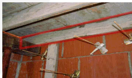
Inchiodatura prima parallela "costa" con precisione
