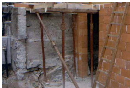
Puntellamento carpenteria pianerottolo/solaio
