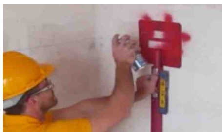
Traccia a parete collocamento impianti
