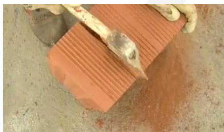
Taglio mattone della misura necessaria
