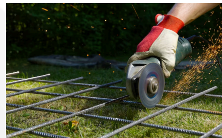
Taglio rete con elettroutensili
