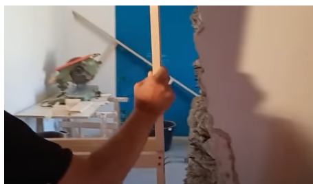
Posa telaio nel punto di alloggio predisposto
