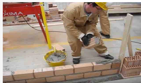
Posa malta sul laterizio posato e posa laterizio in elevazione
