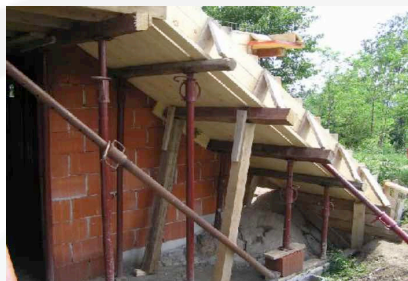
Posizionamento puntelli, banchine e tavole di costa
