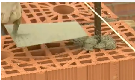
Posa ferri nei fori e chiusura con malta
