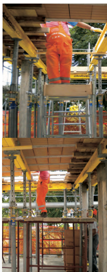
Posizionamento trabattelli / cavalletti
