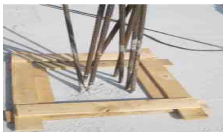
Identificazione ferri di ripresa oggetto di intervento
