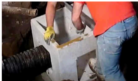
Posa pozzetti in area di posa
