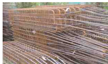
Accatastamento travi assemblate
