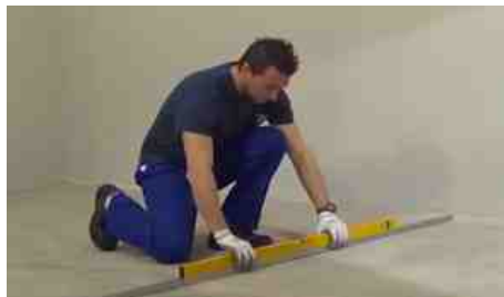
Controllo della planarità del sottofondo
