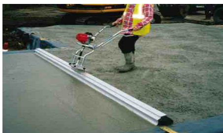
Tiro del massetto a macchina
