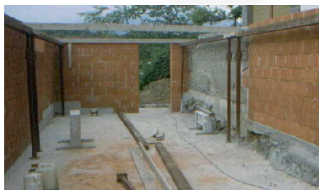
Posizionamento parallele di costa
