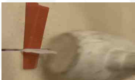
Rimozione distanziatori con martello manuale
