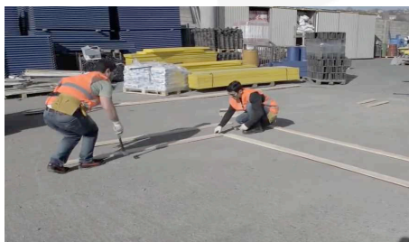
Fissaggio tavole perimetrali
