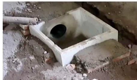
Chiusura con malta e ricoprimento con terra
