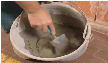
Preparazione delle malte cementizie
