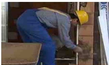
Fissaggio con malte del controltaio
