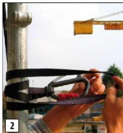
2 - fissare ancoraggio con nodo a strozzo sulla verticale dell'infortunato
