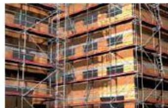
Ponteggio per facciata
