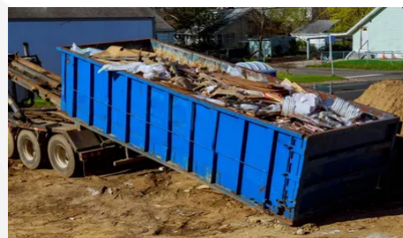
Trasporto dei detriti fuori dal cantiere
