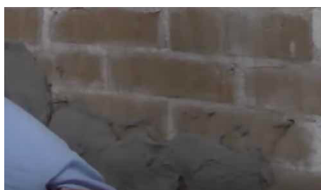
Posa malta a mano o con impiego di macchina
