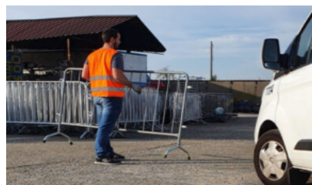
Posizionamento transenne in area di progetto
