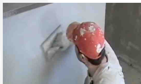
Applicazione e finitura con intonachino
