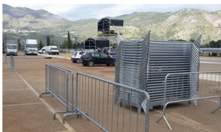
Scarico del materiale a terra
