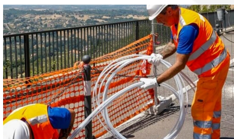
Posa cavi di alimentazione
