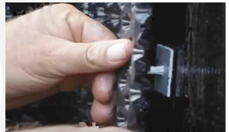
Fissaggio fondalina con bottoni di fissaggio
