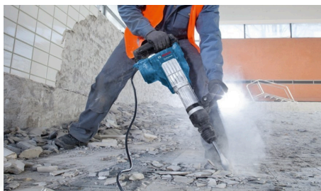
Inizio opere di demolizione previste di progetto
