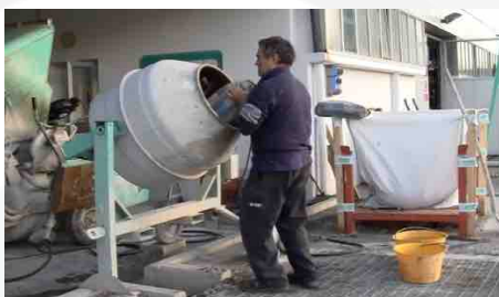
Aggiunta di cemento
