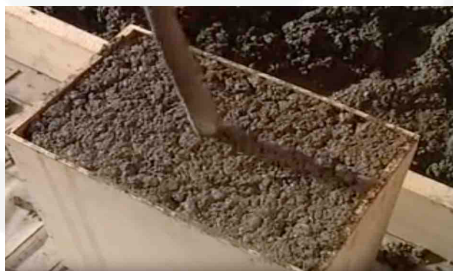
Inserimento dell'ago vibrante in posizione verticale
