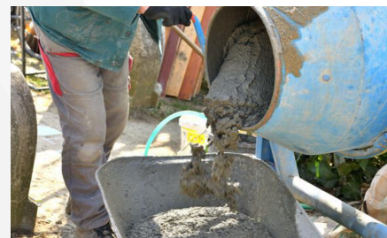
Svuotamento malta in carriola
