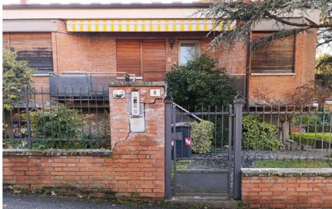
Vista frontale della porzione di muretto adiacente a ingresso pedonale
