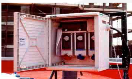
Posizionamento quadro/i elettrico/i
