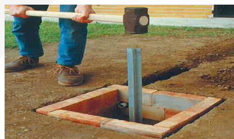
Posa palina di messa a terra
