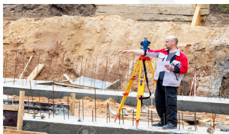
Effettuazione di misurazioni in cantiere
