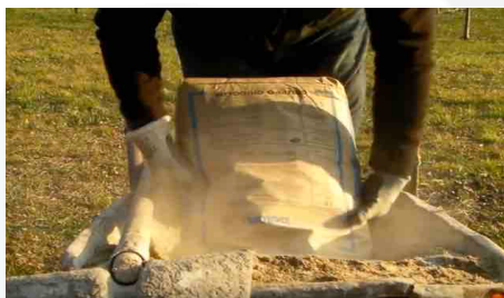
Aggiunta di cemento alla sabbia
