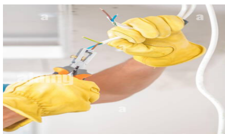
Preparazione cavi per l'immorsettamento
