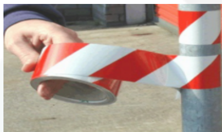
Fissaggio nastro a strutture esistenti
