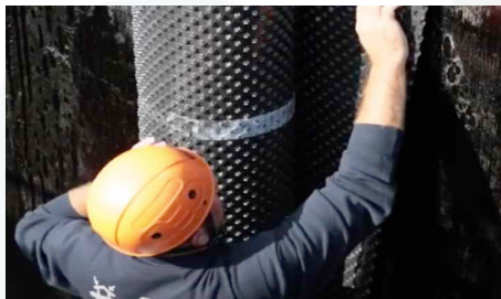
Srotolamento fondalina su superficie impermeabilizzata
