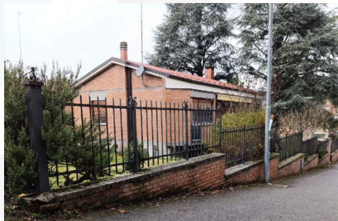
Vista muretto di cinta e recinzione parte alta di via Ludovico Ariosto
