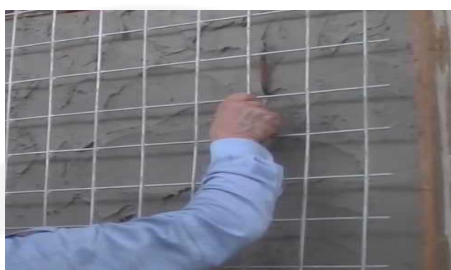
Posa rete elettrosaldata
