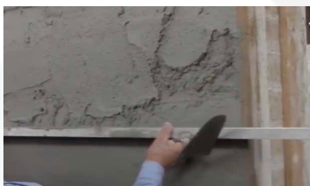
Staggiatura della superficie
