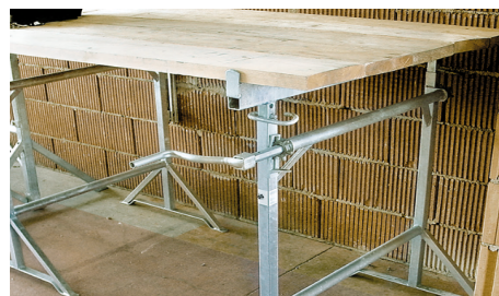
Posa in area oggetto di intervento
