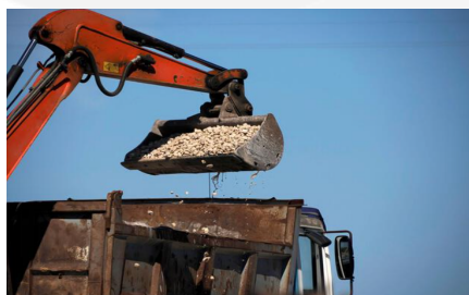
Scarico nello scavo
