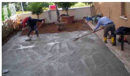
Stesura del calcestruzzo mediante rastrello
