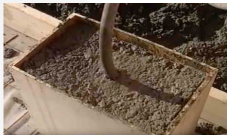
Fase di costipamento
