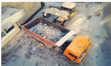
Carico dei detriti su camion
