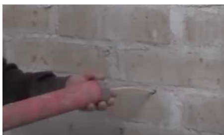
Effettuazione di fori e pulizia
