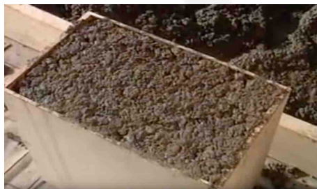
Fase di getto conclusa
