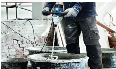
Miscelazione con trapano miscelatore
