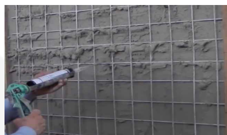
Fissaggio barre con resina chimica
