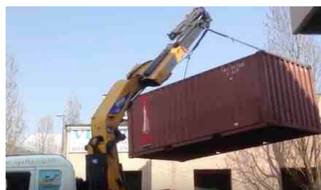
Scarico dei servizi di cantiere
