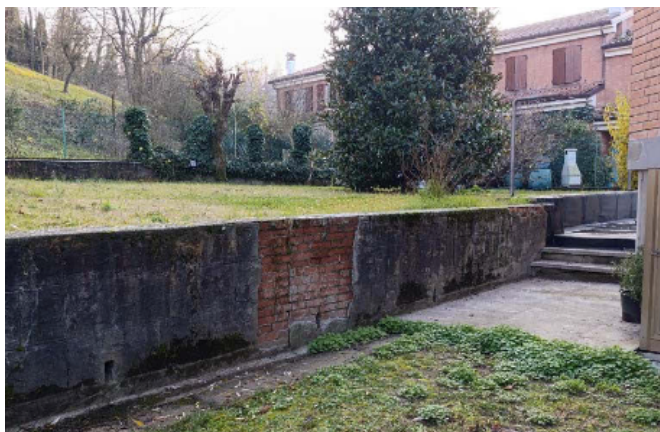
Vista del muretto di contenimento ammalorato
