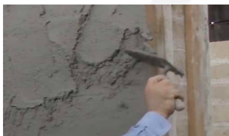
Ricopertura rete con ulteriore strato di malta
